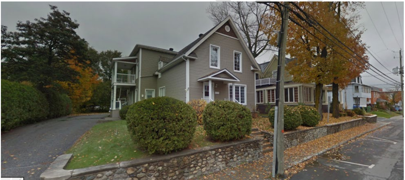
Image 4: Densification de l'habitation (unifamiliale à trifamiliale) - Magog (quartier central avec maisons centenaires) Source image : Google Street View (octobre 2018)
